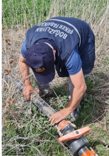
Resim 3.25. Sulama borusu bağlantısının yapılması işlemi
