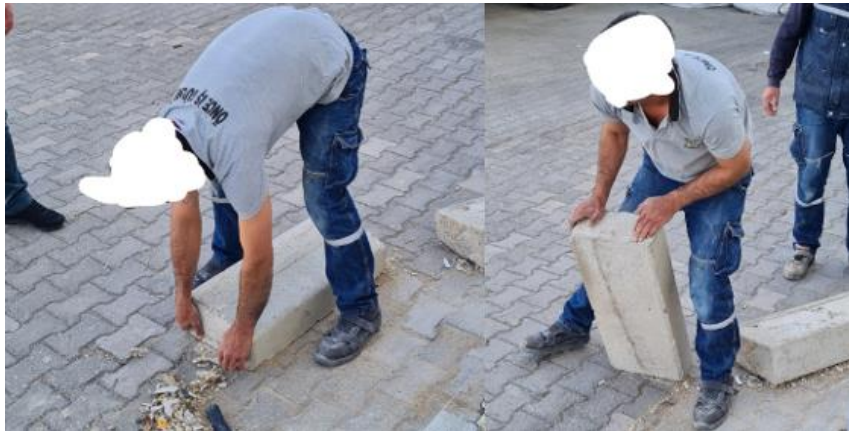
Resim 3.43. Bordür taşı uygulaması işlemi
