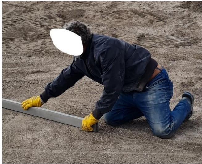
Resim 3.13. Parke uygulamasında kumun düzeltilmesi işlemi
