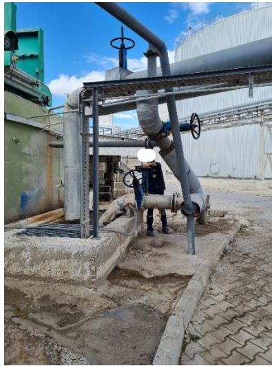
Resim 3.36. Su hazırlama birimi ventillerin açılıp kapatılması işlemi
