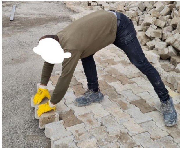
Resim 3.15. Parke uygulamasında parke taşının yerine konulması işlemi
