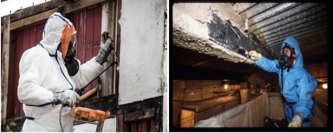
Resim 4.1 Asbestli Numune Alma
