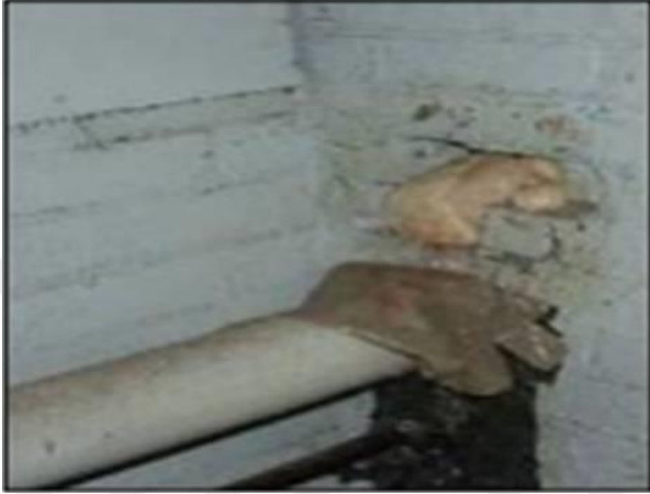
Resim 6.2 Açık alanların köpikle kapatılması uygulaması (İş Sağlığı ve Güvenliği Genel Müdürlüğü, 2019).
