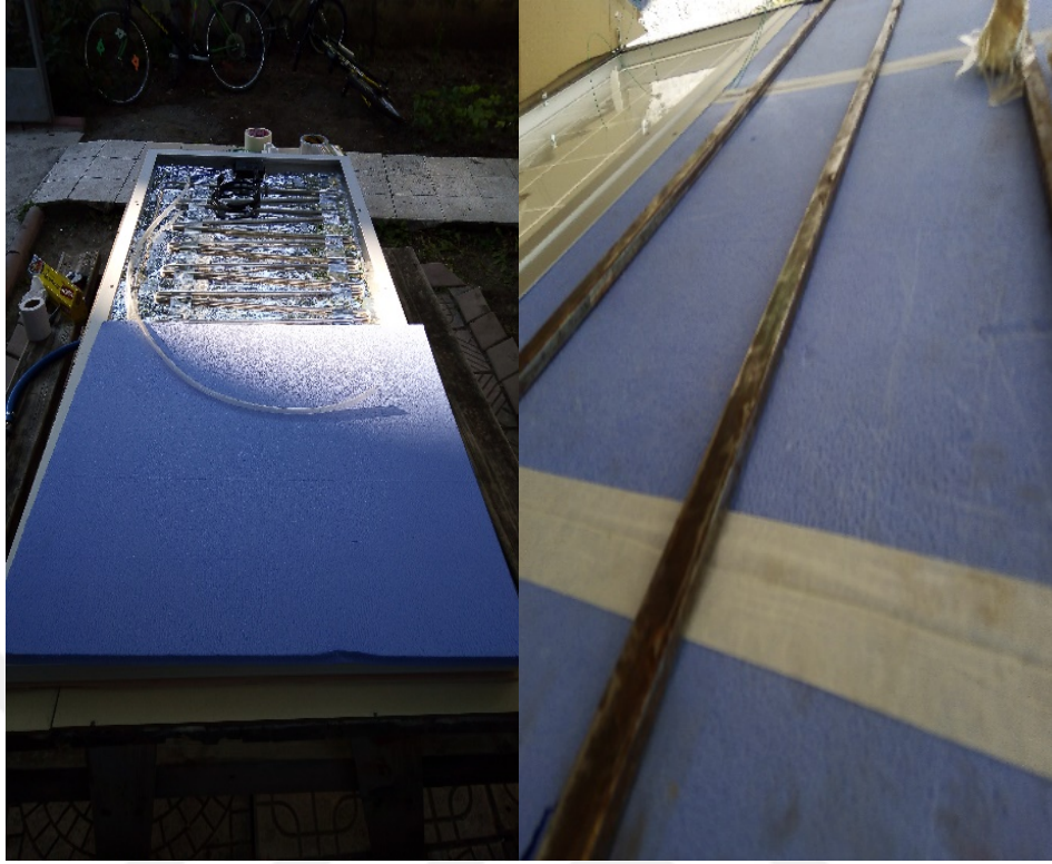
Resim 3.8. Fotovoltaik ısıl modül arka yüzeyinin polistren levha ile kapatılarak izolasyon işleminin yapılması
