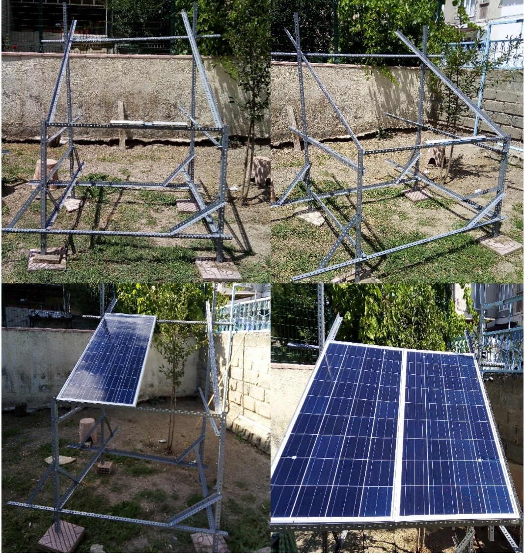
Resim 3.1 Profil sehpa kurulum aşamaları
