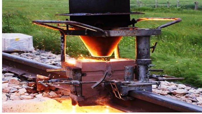
Resim 1.3. Alümina termit ray kaynağı
