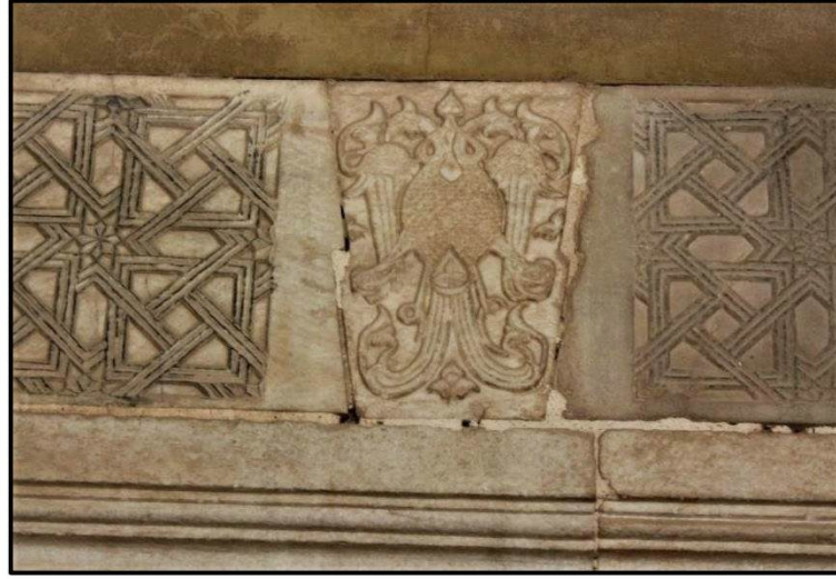
Resim 3.116: Hacı Bektaşî Veli Türbesi giriş kapısı 518
