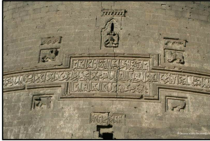
Resim 3.53: Ulu Beden Burcu dış cephesi 437
