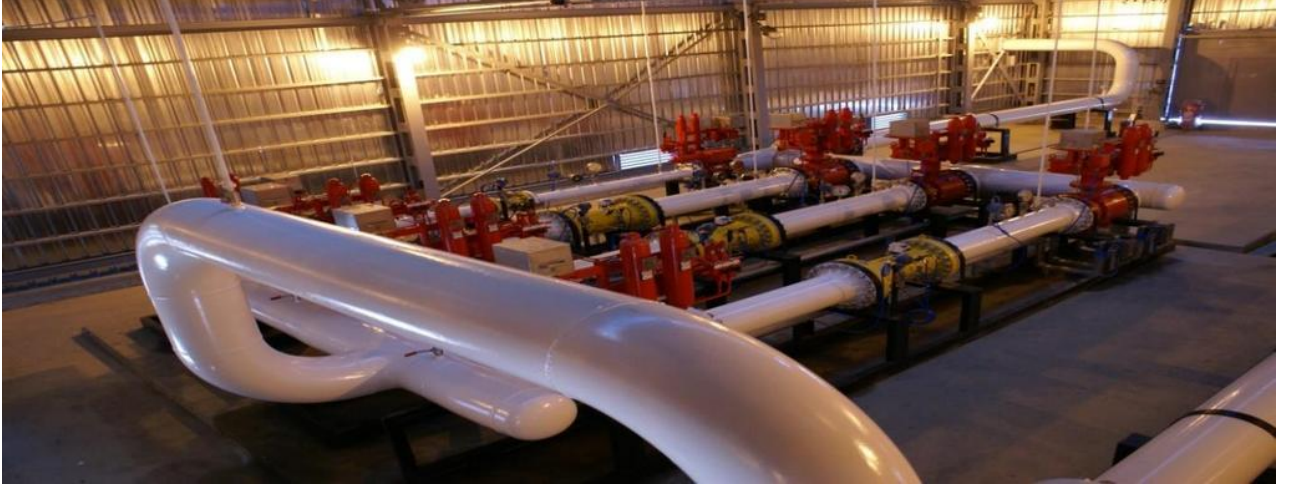
Şekil 1.10. A tipi basınç düşürme ve ölçüm istasyonu görseli
