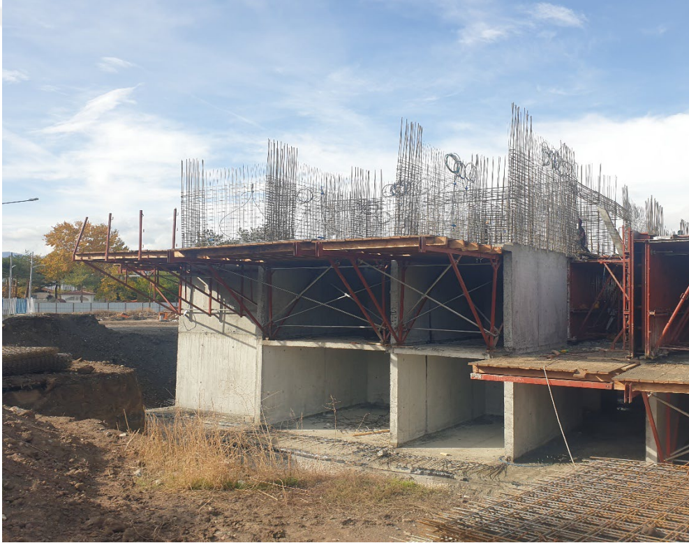
Şekil 1.2. Tünel kalıp sistemi.
