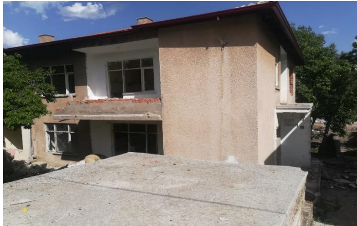
Resim 4.7. 4 Nolu Numune Yozgat Menekşe Evleri Kentsel Dönüşüm Bina Dışı
