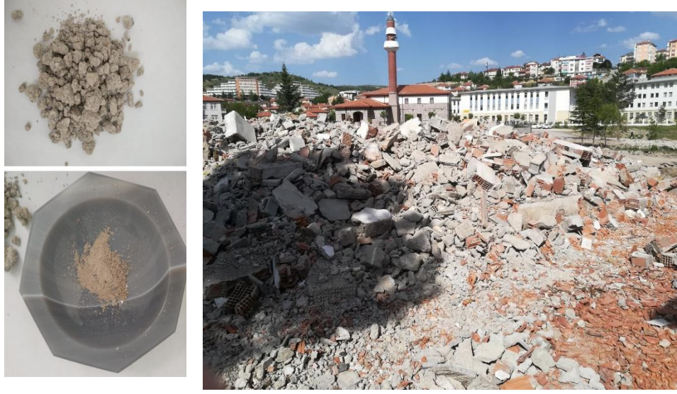
Resim 4.8. 4 Nolu Numune Yozgat Menekşe Evleri Kentsel Dönüşüm Kolon Malzemesi
