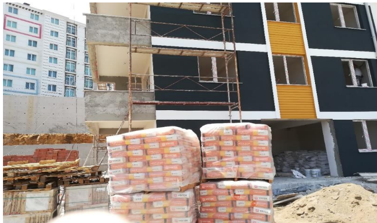
Resim 4.1. 1 Nolu Yozgat Bahçelievler Mahallesi Yeni İnşaat Alanı Bina Dışı
