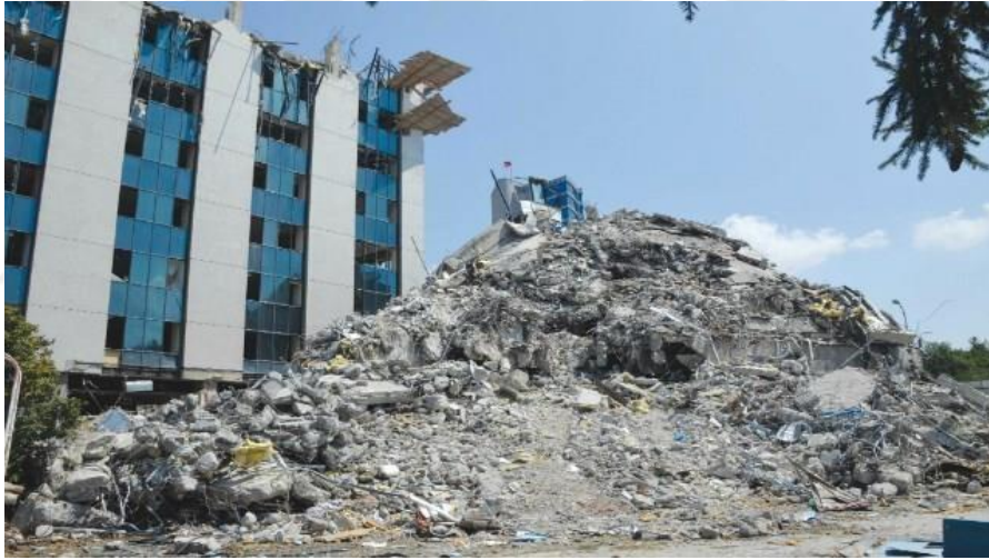
Resim 1.3. İnşaat ve Yıkıntı Atığı Oluşumu (Pamuk, 2018)
