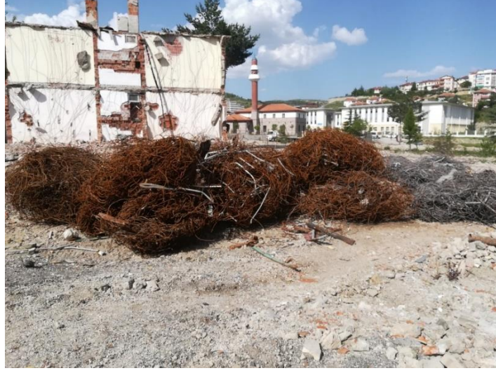
Resim 4.5. 3 Nolu Numune Yozgat Menekşe Evleri Kentsel Dönüşüm Bina Dışı
