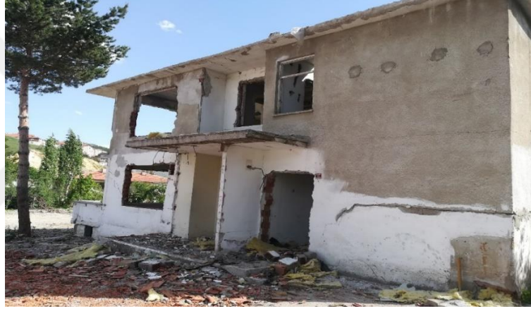
Resim 4.3. 2 Nolu Numune Yozgat Menekşe Evleri Kentsel Dönüşüm Bina Dışı
