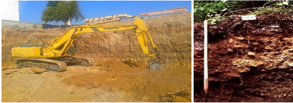
Resim 1.1. Hafriyat Kazı Çalışması ve Bitkisel Toprak Kesiti (Pamuk, 2018)
